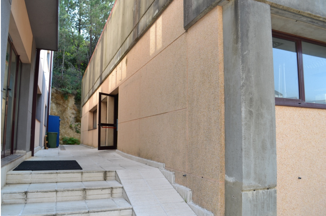
Fachada noroeste de nave piloto
