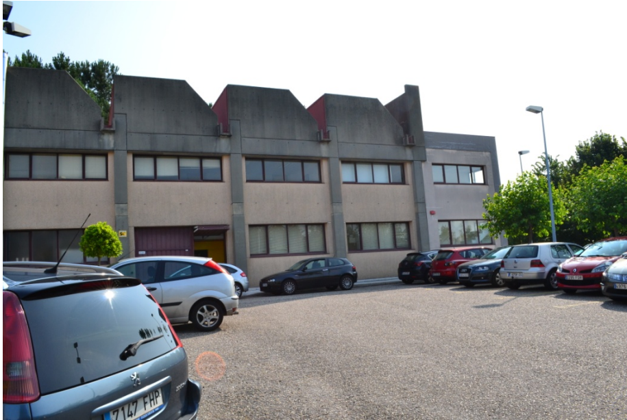
Fachada noreste de nave piloto y anexo
