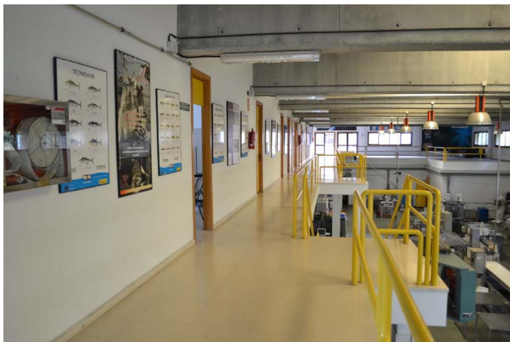
Entreplanta nave piloto
