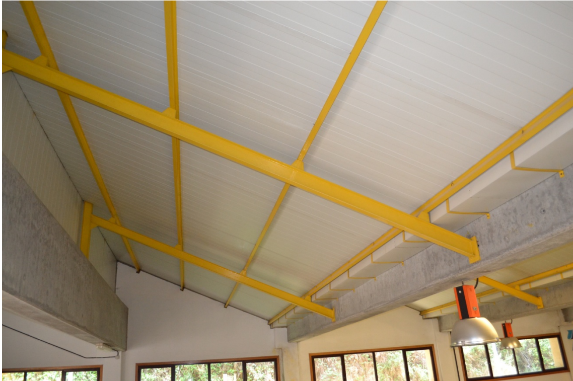
Detalle de cubierta por el interior de la nave piloto
