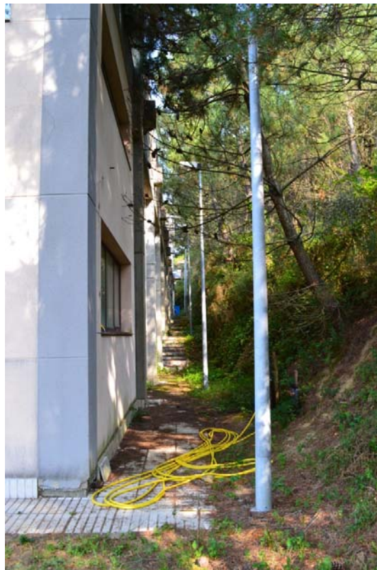
Fachada noreste de anexo y nave piloto
