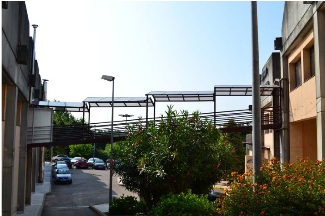
Pasarela de conexión de nave piloto con edificio de Anfaco
