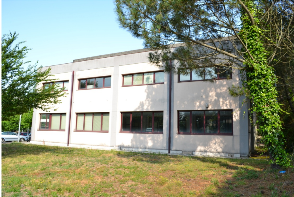
Fachada sureste de anexo
