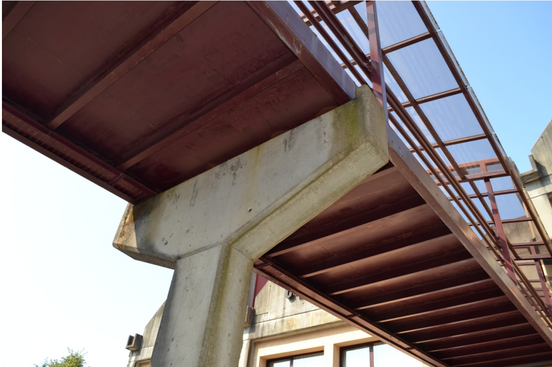
Detalle de pasarela metálica
