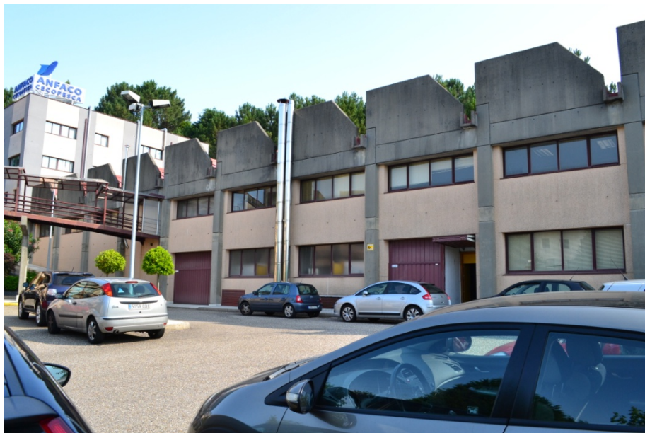
Fachada noreste de nave piloto
