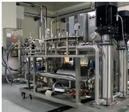
Sistema de filtración con membranas
